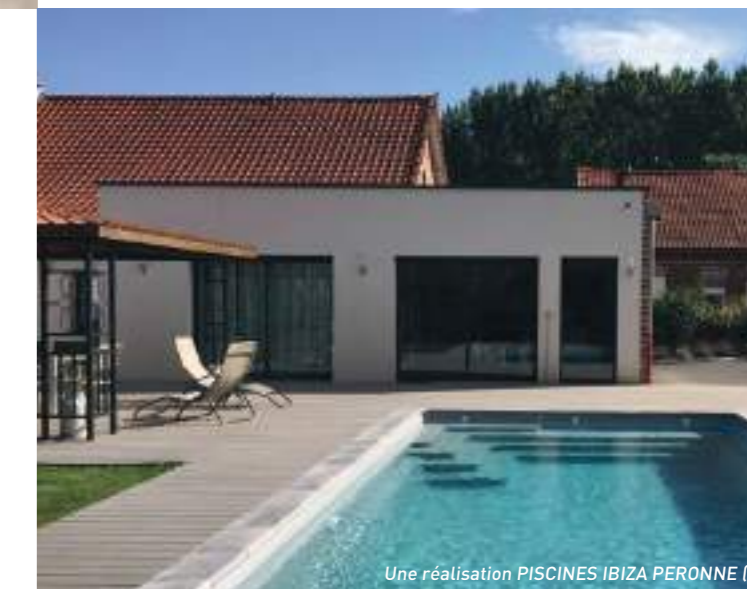
Une réalisation PISCINES IBIZA PERONNE (80)
