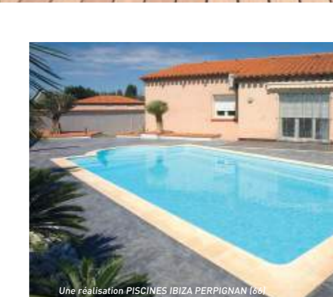
Une réalisation PISCINES IBIZA PERPIGNAN [66]
