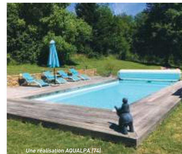
Une réalisation AQUALPA (74)
