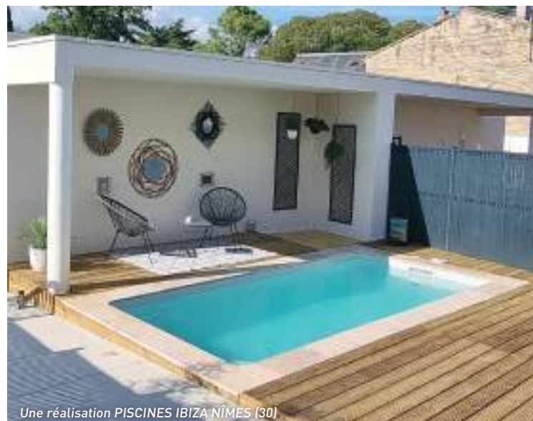
Une réalisation PISCINES IBIZA NÎMES (30)
