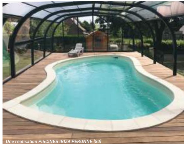
Une réalisation PISCINES IBIZA PERONNE (80)
